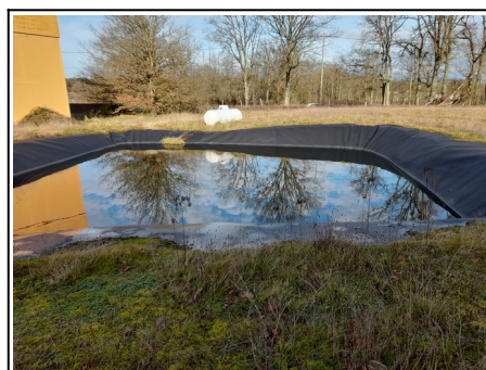
Photo n°20: vue bassin de rétention de 50 m 3
