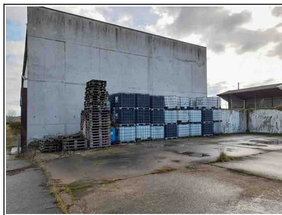
Photo n°2 : Vue bâtiment industriel et stockage GRV
