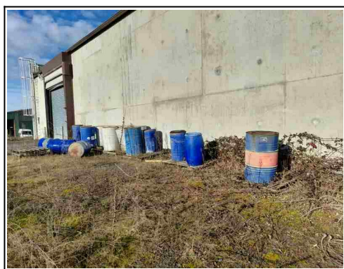
Photo n°17 : Déchets en extérieur
