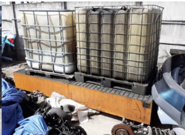
Cuve non identifiées en extérieur, sur rétentions partiellement pleine d'eau
