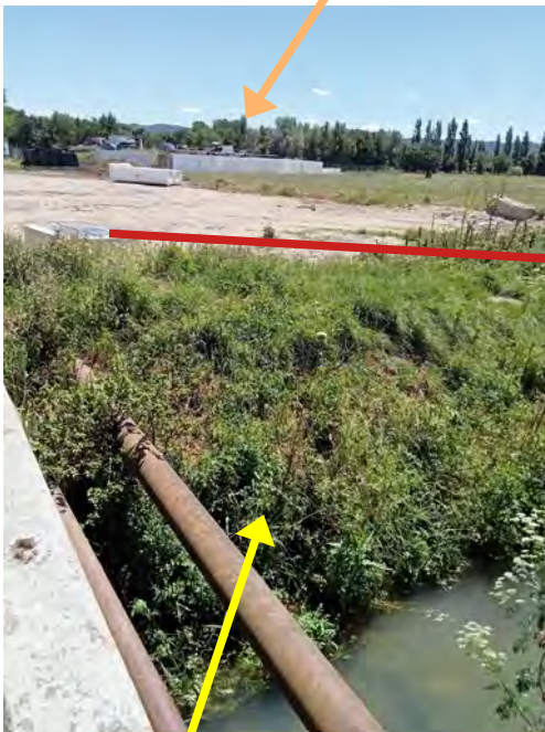
Exutoire eaux pluviales
