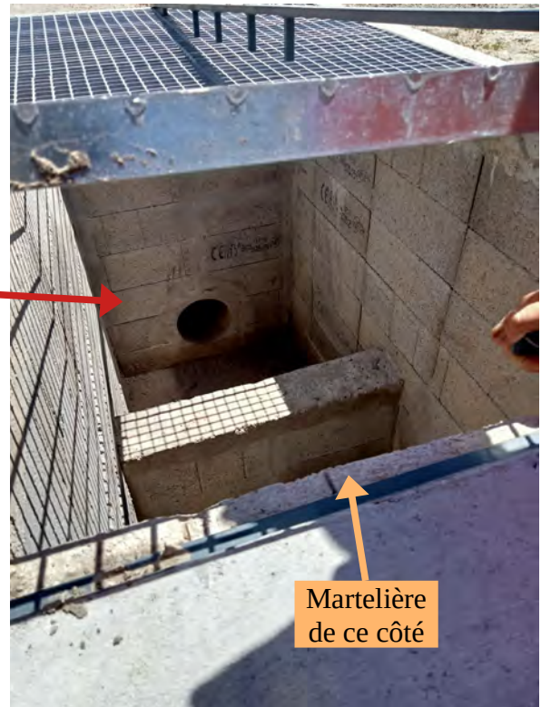
Aménagement pour martelière d'isolement du réseau de collecte d'eaux pluviales et donc des eaux d'extinction incendie en amont de l'exutoire final
