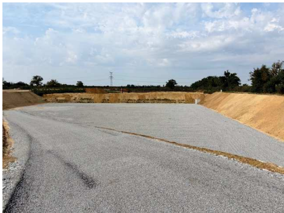
Casier 2 achevé (couche drainante)
