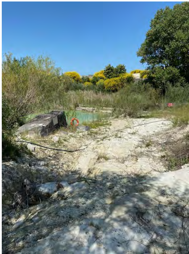
Photo n° 10 – panneautage au devant des bassins de décantation
