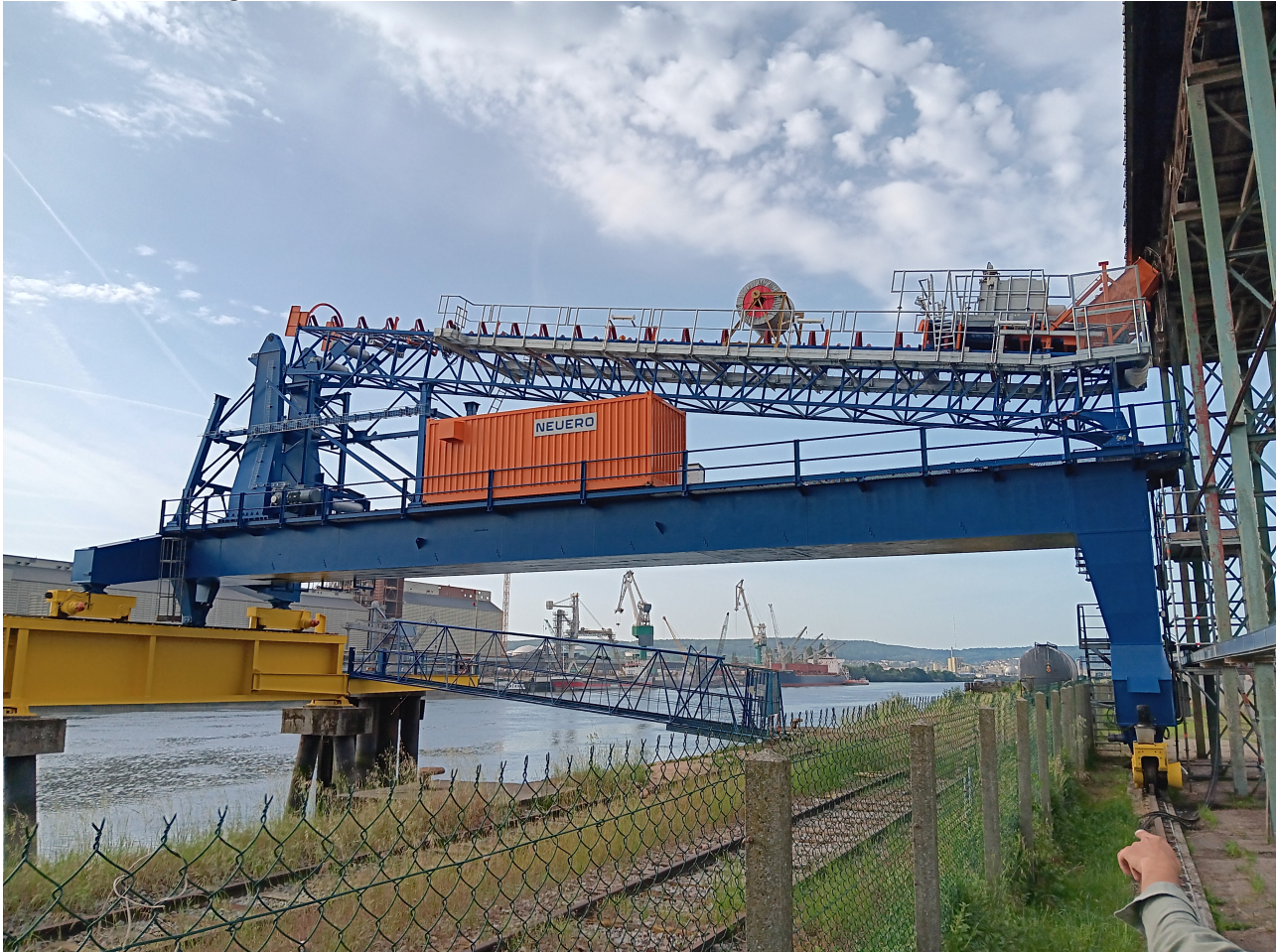
nouveau portique de chargement
