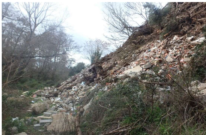
Vue du pied de remblai
