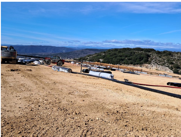
Travaux de couverture en cours sur Roussas 2
