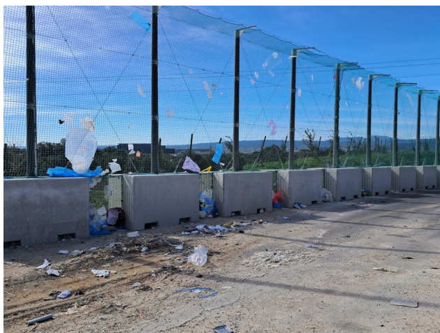
Filets au Sud du casier 1 de LCJ 3
