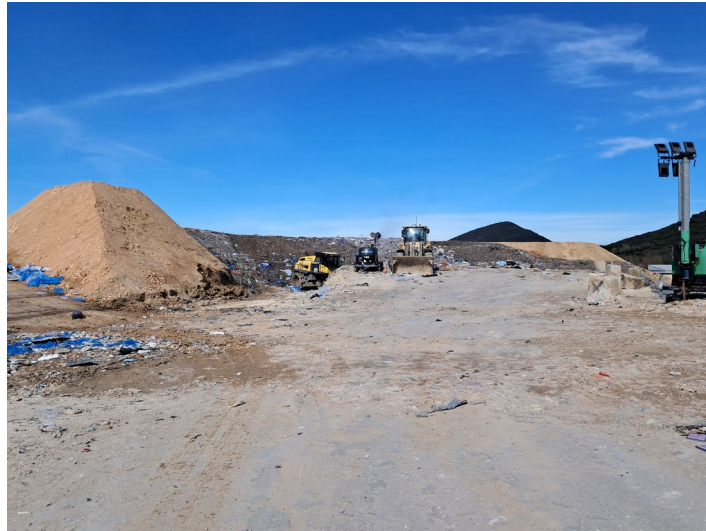
Appareil de diffusion de déodorant au droit du quai de vidage du casier 1
