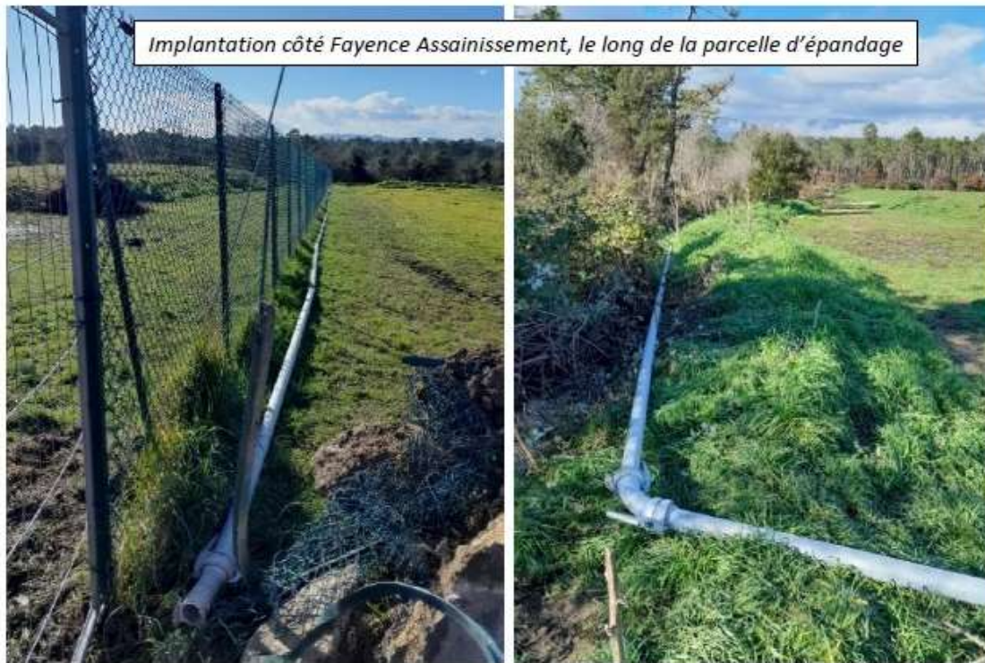
Canalisation fixe en acier galvanisé
