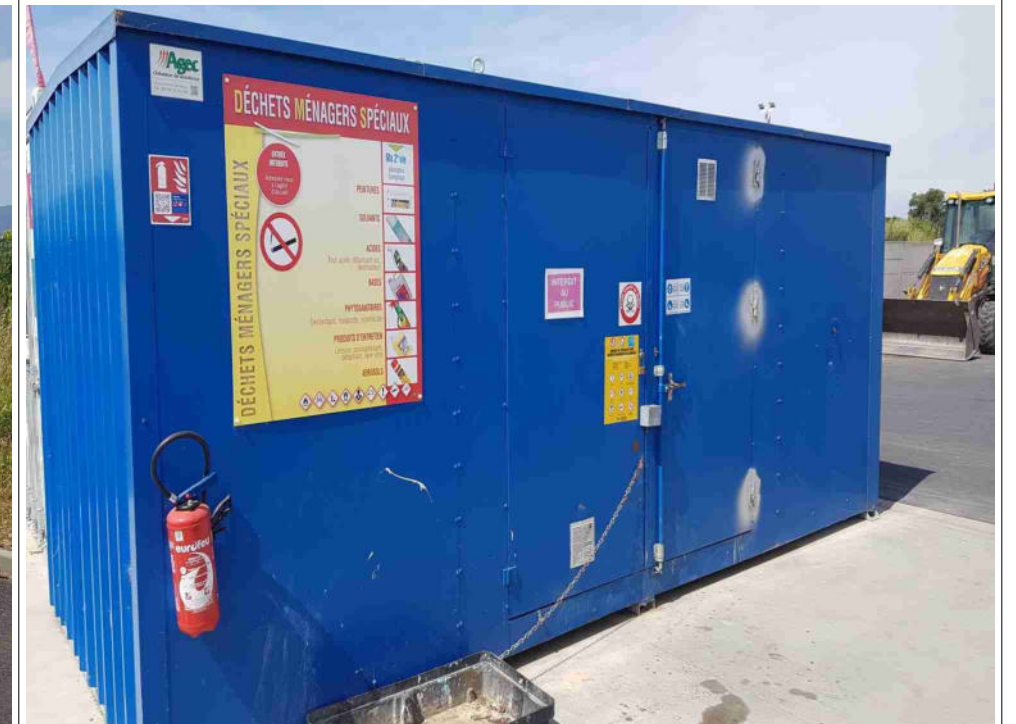
Extincteur fixé au conteneur dans lequel sont entreposés les déchets diffus spécifiques (communément dénommés déchets ménagers spéciaux)
