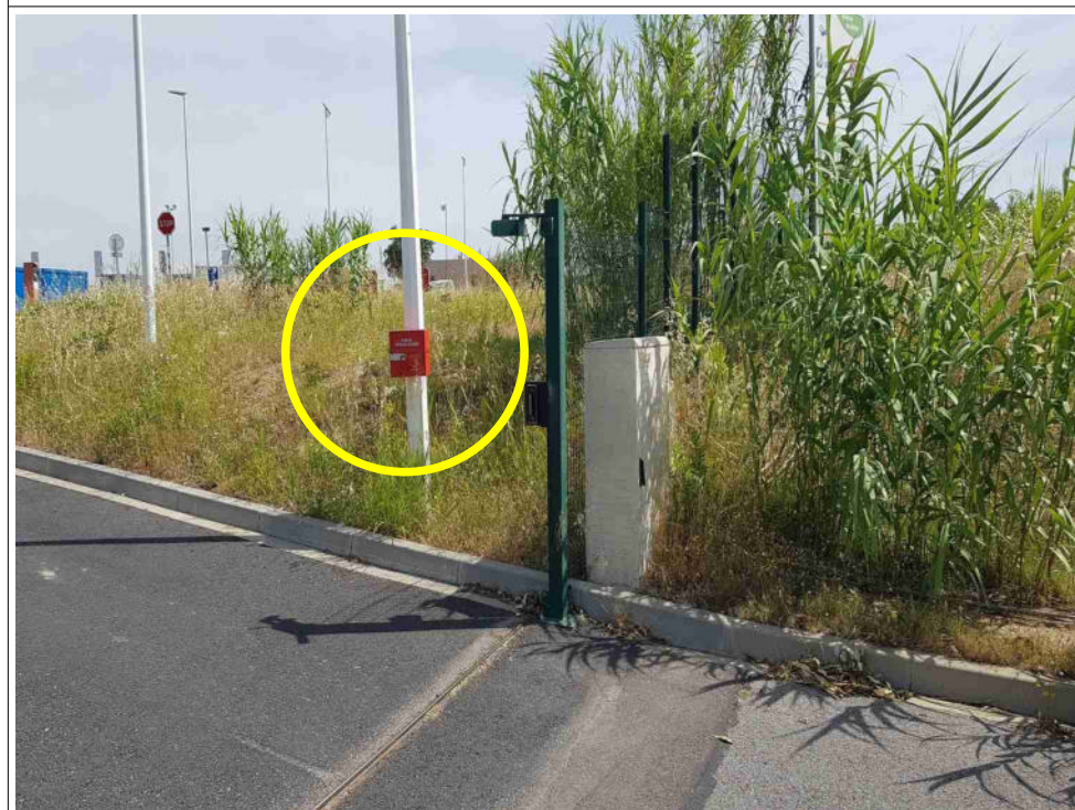
Boîte à clé « pompiers » contenant le plan de défense contre l'incendie et ses mises à jours installée à l'entrée de la déchèterie
