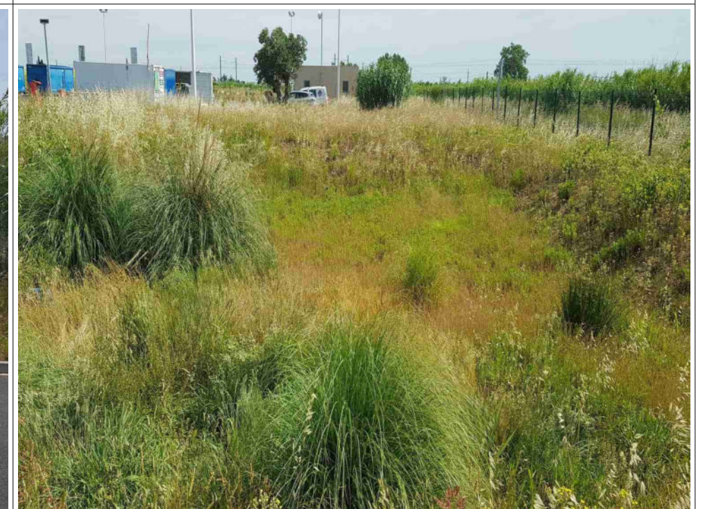
État de la végétation présente dans le bassin de récupération des eaux pluviales à la date du contrôle, résorbé par une opération de débroussaillage, avant la date de rédaction du rapport du contrôle
