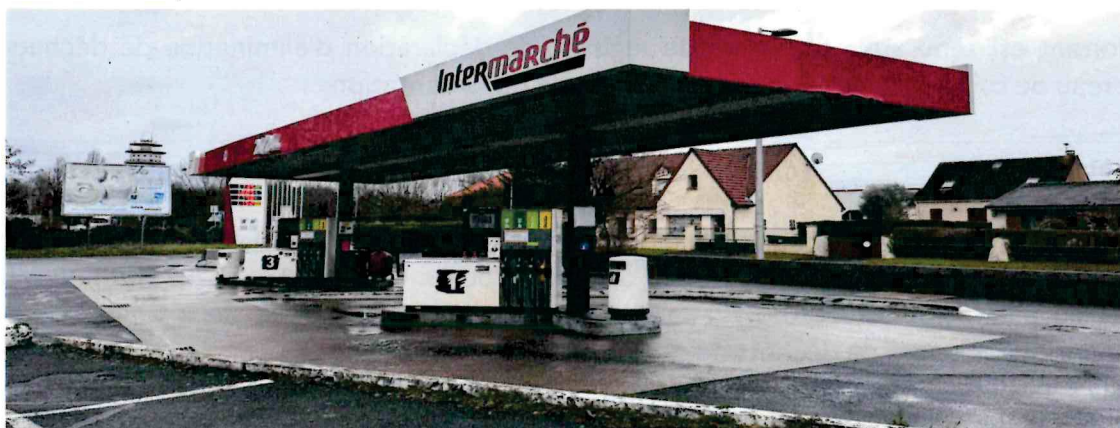
Aire de distribution
