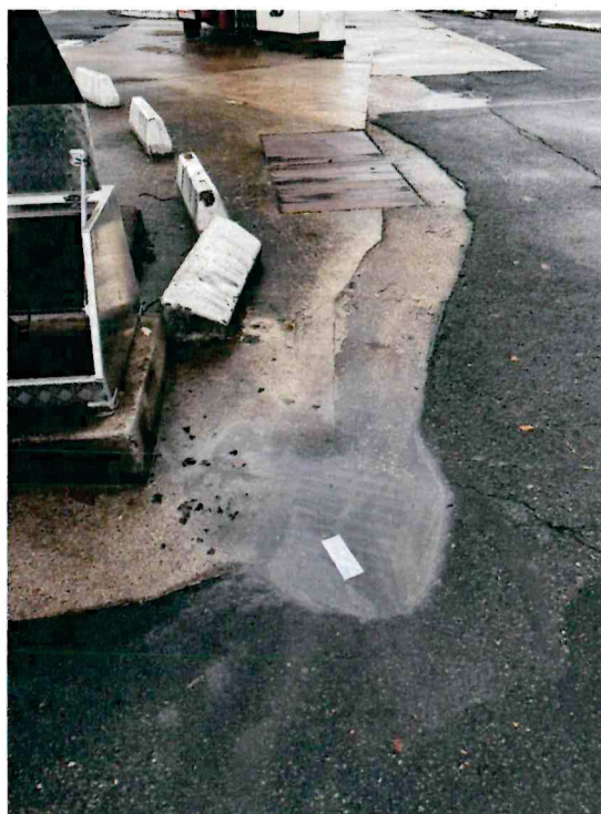
Point bas de l'ilot n°4 et de l'aire de dépotage
