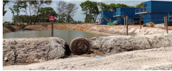
clôture bassin 3 fils
