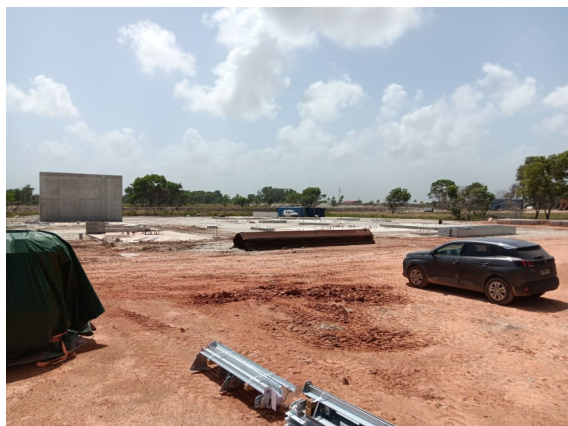
Terrassement installation de traitement
