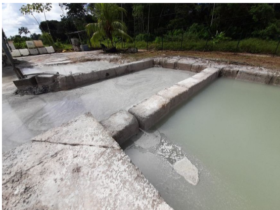
Bassins de décantation
