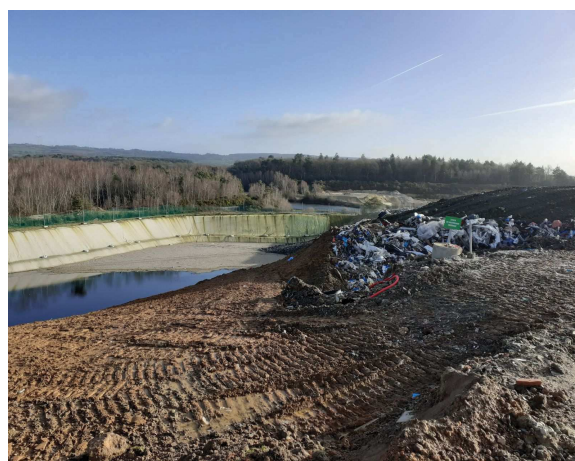
Vue depuis casier 2.15 vers 2.14 (au fond, zone du sinistre)
