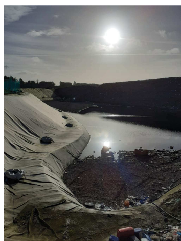
Point bas des eaux d'extinction (casier 2.15)
