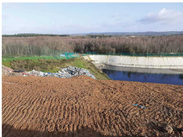
Vue du casier 2.14 (terres utilisées pour étouffer incendie)
