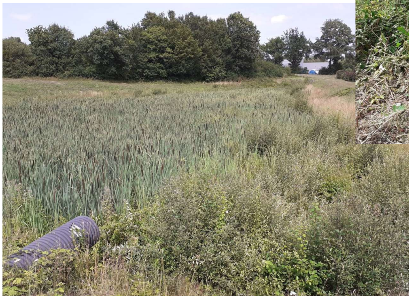
Bassin de rétention des eaux d'extinction incendie et vanne de confinement
