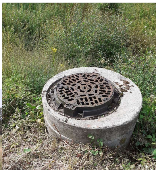
Bassin de rétention des eaux d'extinction incendie et vanne de confinement
