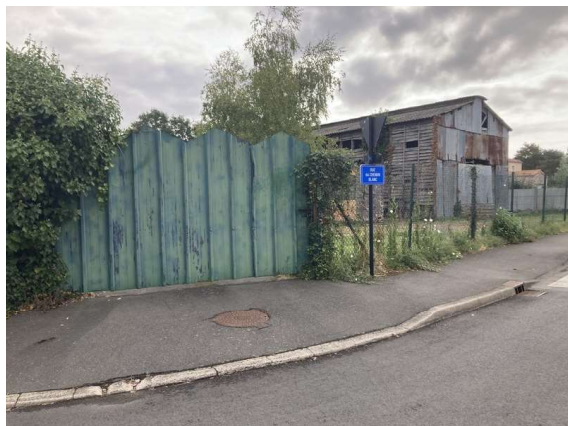
Vue de la rue du chemin Blanc
