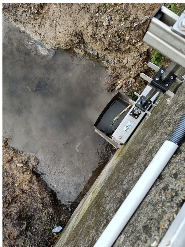
Regard équipé d'un panier filtrant (à gauche) et panier dégrilleur au niveau de l'exutoire vers le fossé sud (à droite)
