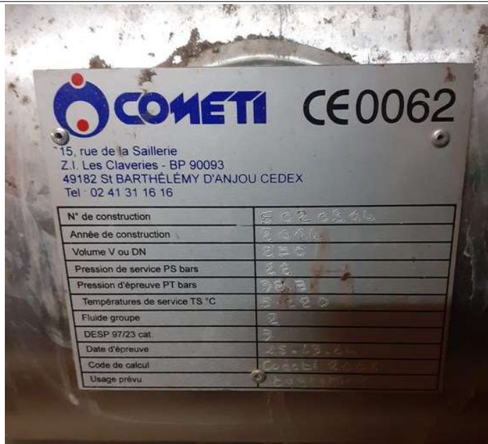
plaque d'identification de la tuyauterie V9
