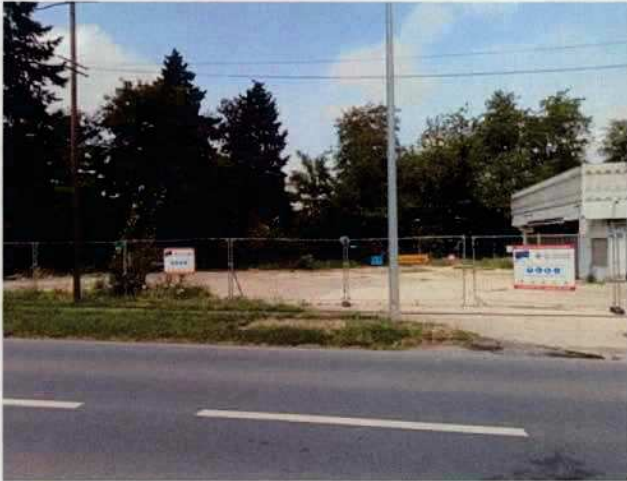
Barriérage du site
