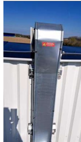
Liaison TGBT DC / onduleurs
