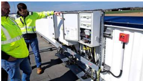
Positionnement TGBT DC et boîtes de jonction
