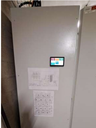
Signalisation schéma électrique unifilaire
