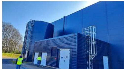
Locaux techniques adossés au mur REI cellule n°1
