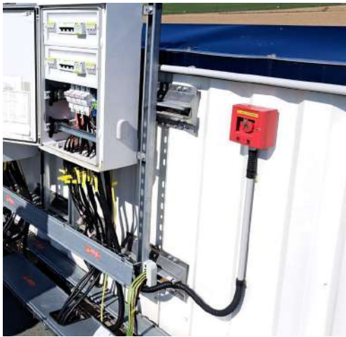
Dispositif de coupure toit
