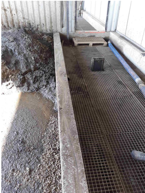
fosse de décantation déchets dangereux
