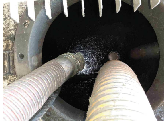
cuve 2 partiellement remplie
