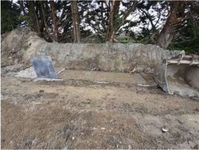
Nouveau réseau de rejet des eaux pluviales en cours de construction
