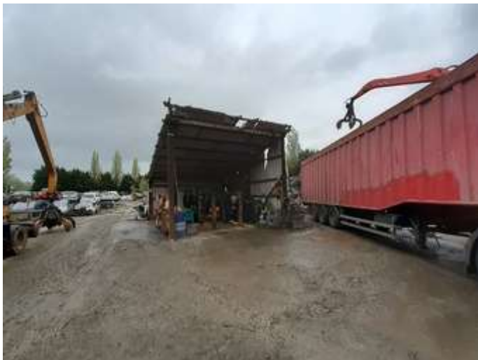
Station de dépollution des Véhicules Hors d'Usage
