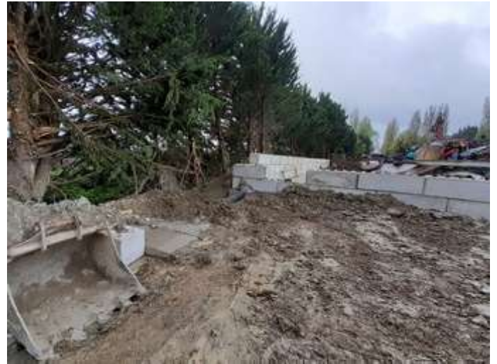
Nouvelle plateforme ceinte d'un mur de type REI 120
