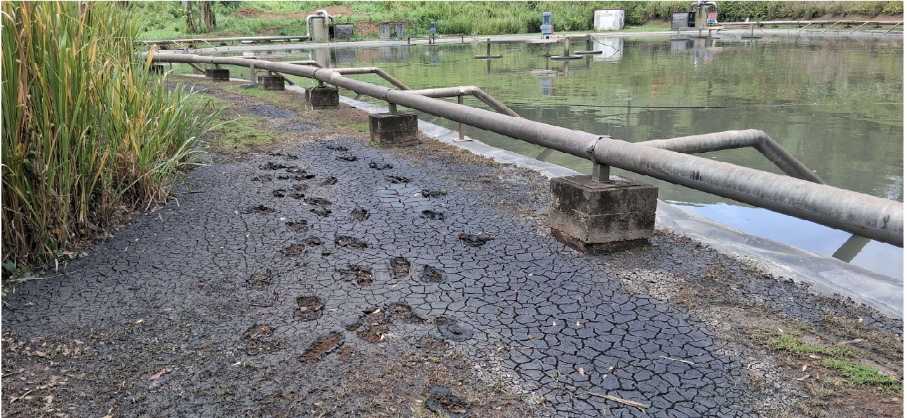
Figure 3: Traces de débordement de vinasses au droit de la lagune B
