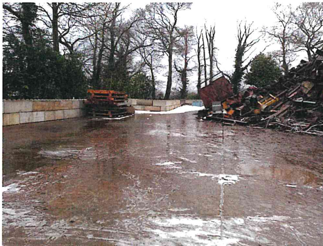
Photo 7 : Zone de rétention partiellement remplie d'un tas de ferrailles (entreposée en dehors de l'aire prévue à cet effet)
