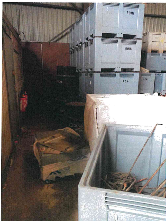
Photo 11 : encombrement de la voie d'accès aux extincteurs
