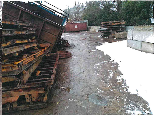
Photo 8 : Zone de rétention partiellement remplie d'un tas de ferrailles (entreposée en dehors de l'aire prévue à cet effet)
