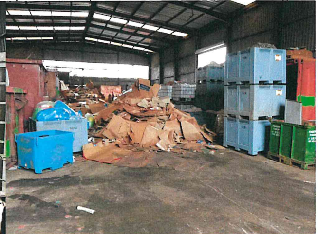
Photo 10 : entreposage anarchique des déchets dans le bâtiment entraînant un fort encombrement de ce dernier
