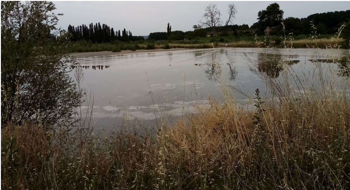
bassin de décantation des boues de lavage entouré par une clôture
