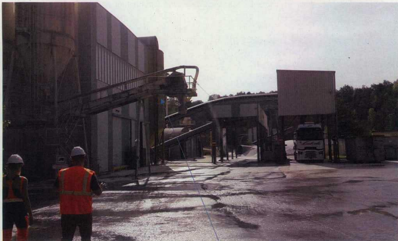
Zone de chargement avec bras de vidange des silos
