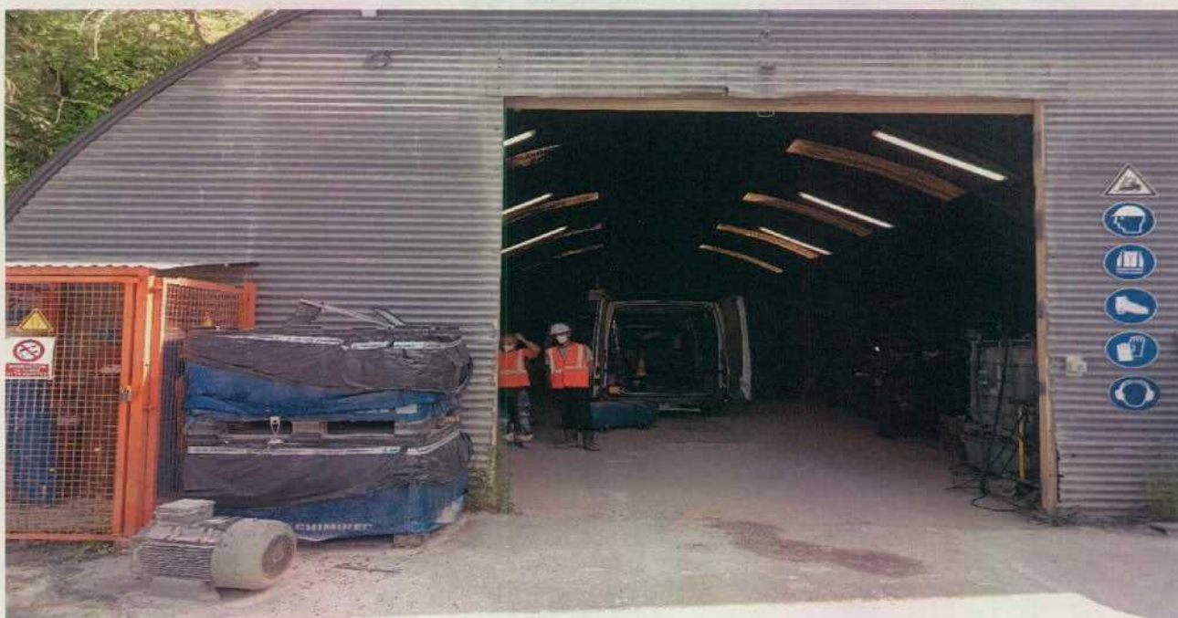
Atelier et zone de stockage de produits dangereux
