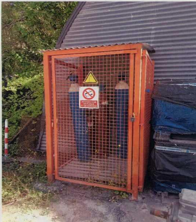
Stockage Oxygène et Acétylène
