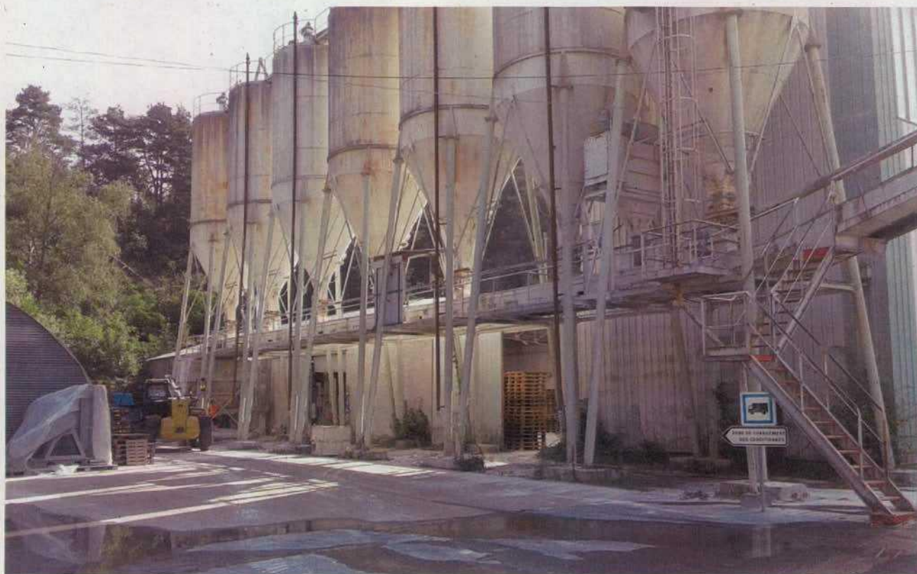
Silos de stockage du sable séché
