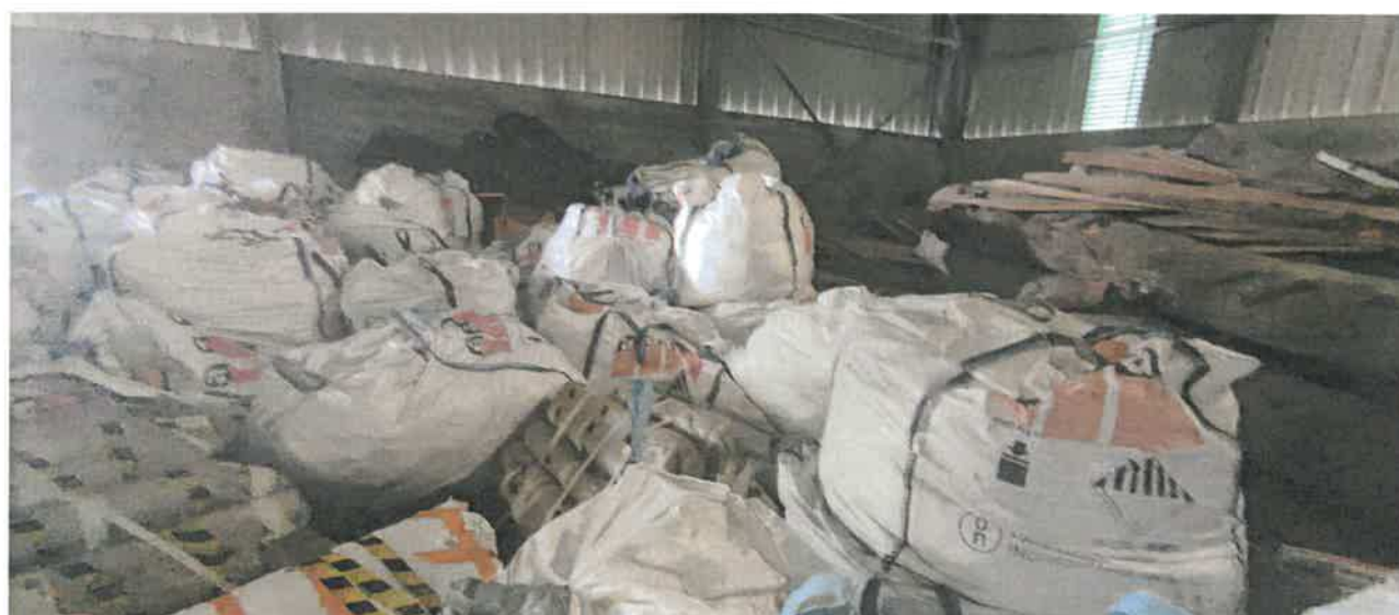
Photographie n° 2 (entreposage de déchets d'amiante en big-bags et sur palettes filmées)
