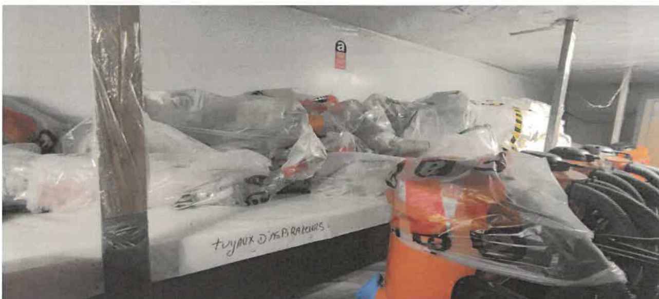
Photographie n° 5 (étagère d'entreposage de déchets d'amiante en sacs dans la zone cloisonnée)
