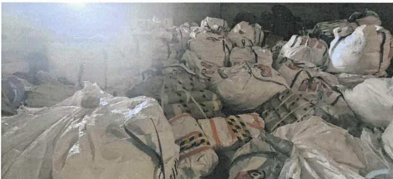
Photographie n° 2 (entreposage de déchets d'amiante en big-bags et sur palettes filmées)
