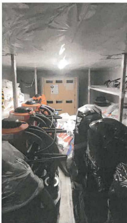
Photographie n° 8 (entreposage de contenants comportant la signalétique de déchets d'amiante dans la zone cloisonnée)
