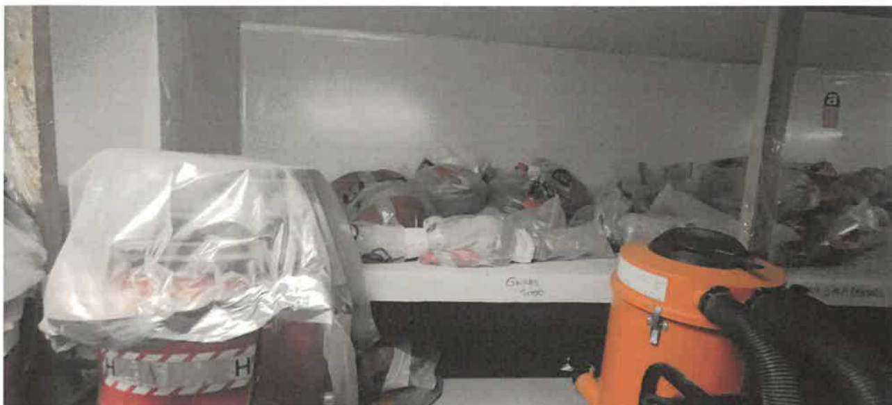
Photographie n° 4 (étagère d'entreposage de déchets d'amiante en sacs dans la zone cloisonnée)
