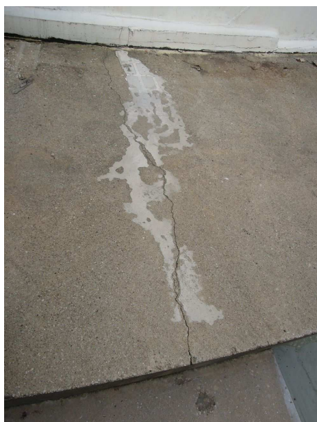
Fissures observées le 29 mars 2023 sur le fond de la cuvette de rétention des réservoirs de FOD
