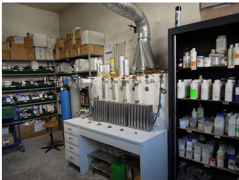
Annexe cosmétique du laboratoire avec arrivée de tuyauteries de propane, butane et DME non équipée de détecteurs de gaz inflammables
