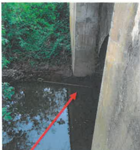
Lisioduc dans cours d'eau BCAE
