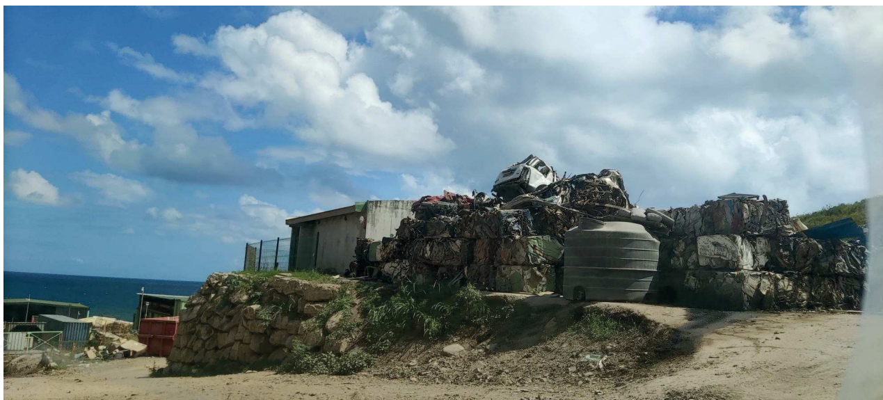
Photographie n° 3 (absence de rétention et écoulements d'huiles hors de la zone ferrailles)
