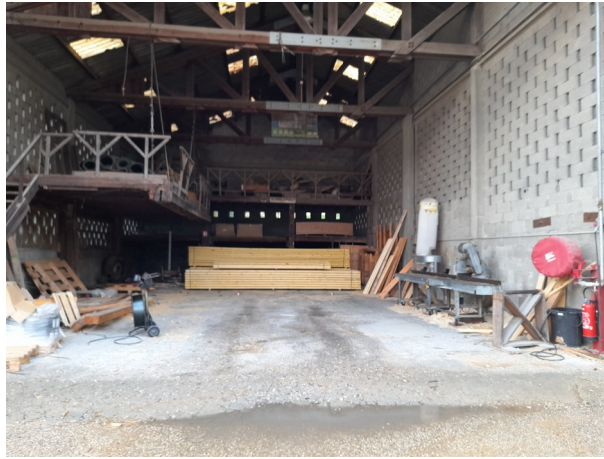
Hangar de stockage pour le séchage
