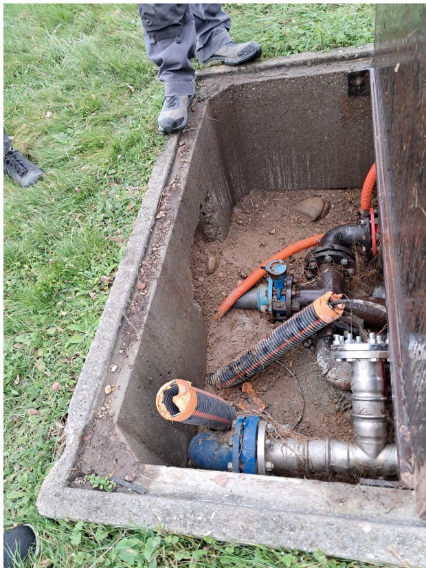
Intérieur du forage P3
