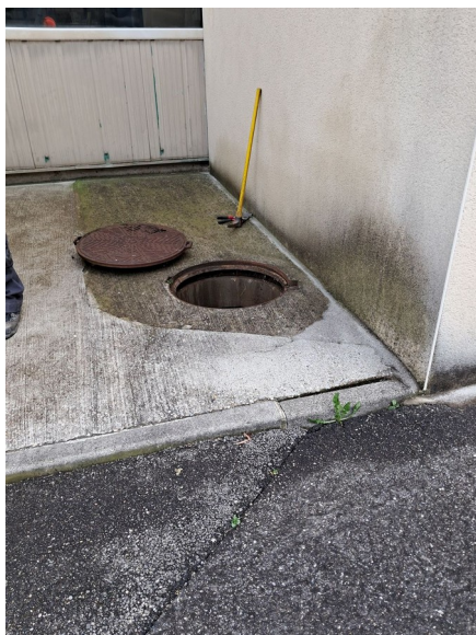
Extérieur du forage P4
