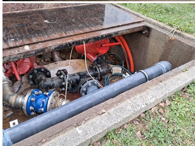
Intérieur du forage P3
