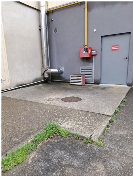
Exterieurs du forage P2 prélèvement
