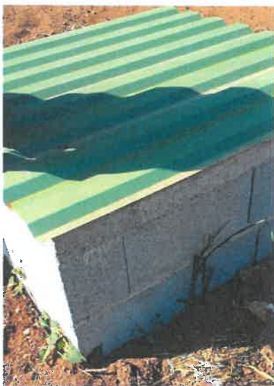
Extérieur du forage
