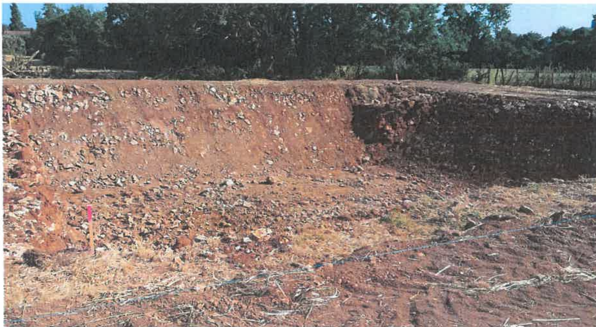
Travaux en cours pour la mise en place d'une fosse géomembrane
