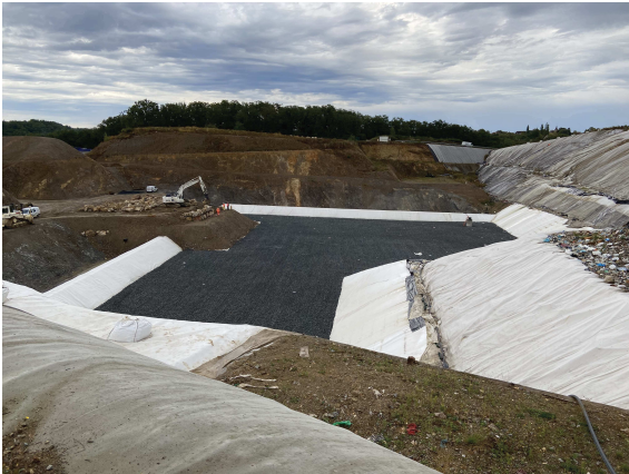
Talus du casier 4.1
