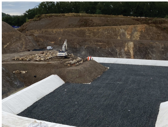
Quai de déchargement du casier 4.1 à finaliser
