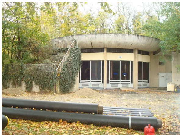
Figure 2: Extérieure de la chaufferie E.Montaigut
