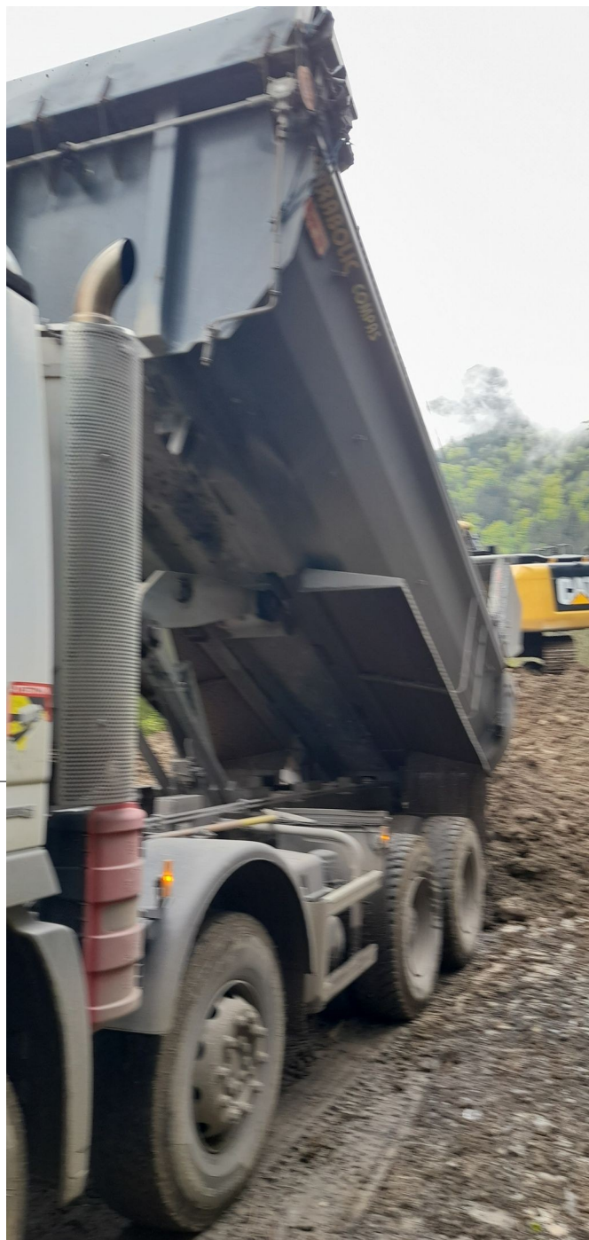
N°1 - Camions déchargeant sur le site
