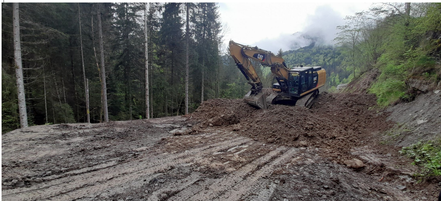
N° 3- Pelle compactant les remblais
