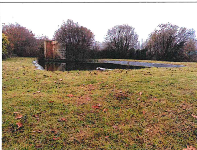
Réserve incendie mutualisée de 300 m 3
