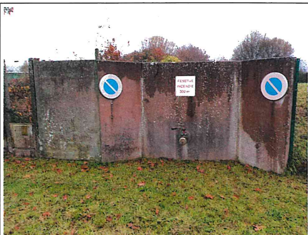
Station de raccordement à la réserve
