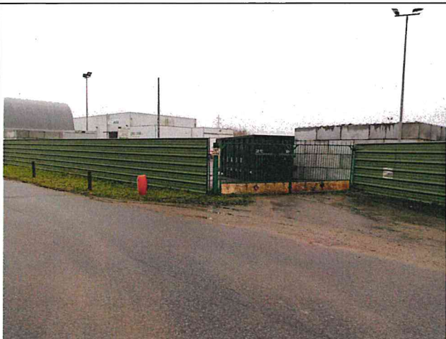
Poteau incendie public situé contre la clôture pleine du site
