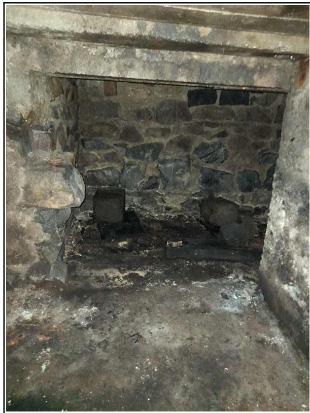
Photo n°7 : Mur de la fosse maçonnée et dalle mitoyenne
