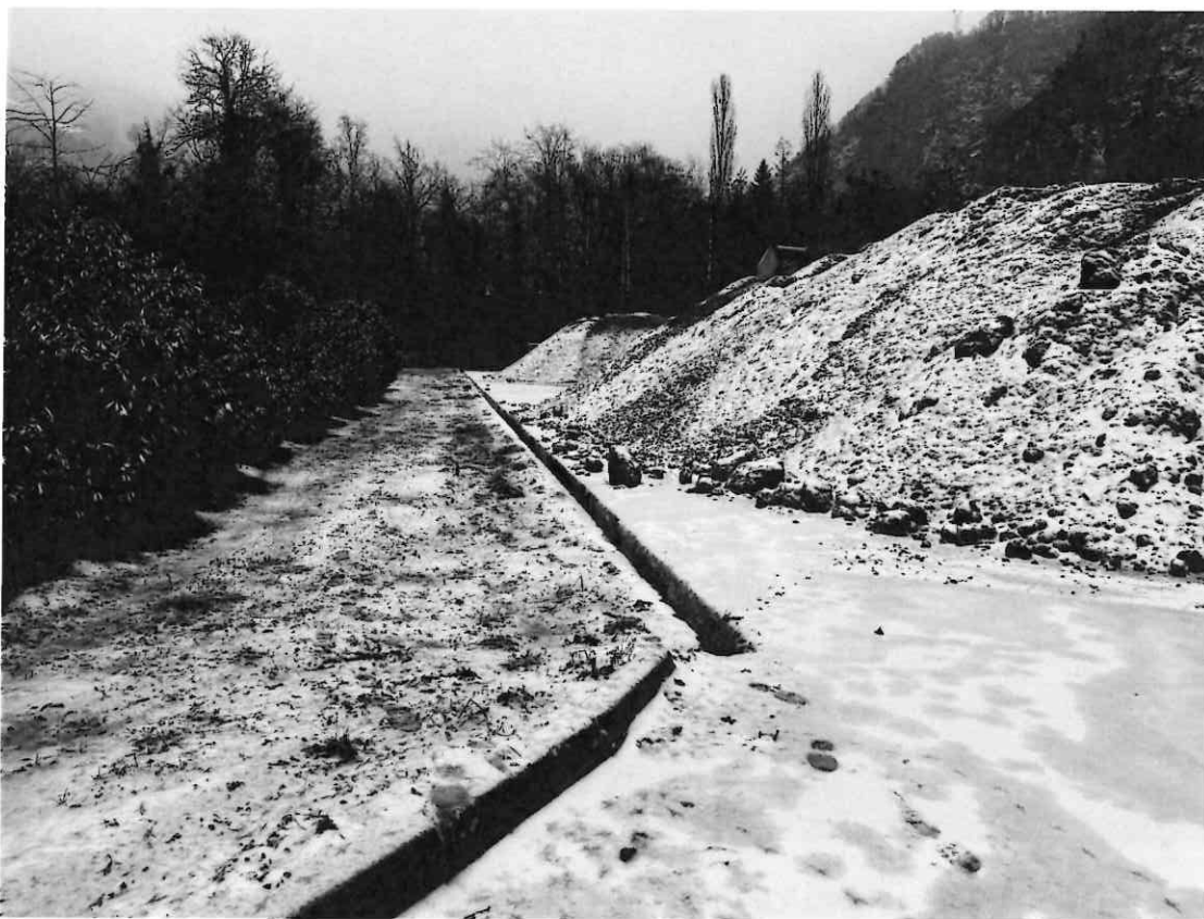
Photo 1 : Caniveau séparant l'aire de maturation des mâchefers et la clôture du site
