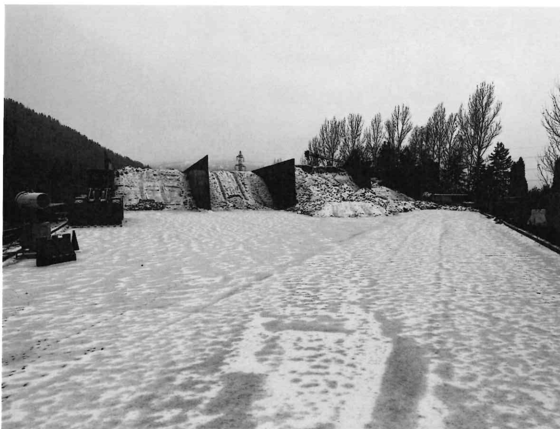
Photo 2 : Alvéoles de stockage des mâchefers et dispositif d'humidification (à gauche)
