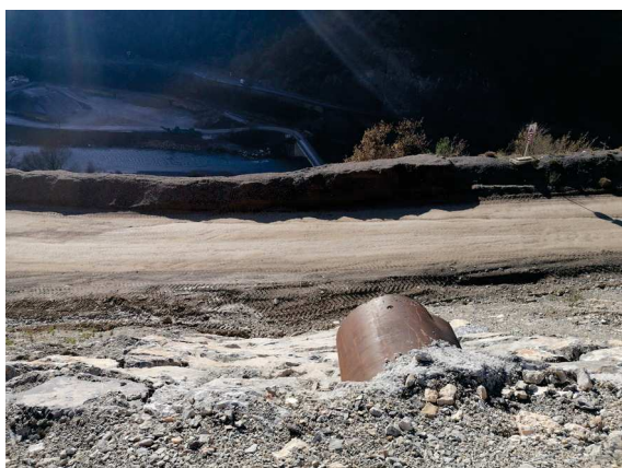
Image n°6 : Enrochement sous le conduit d'évacuation du bassin d'orage
