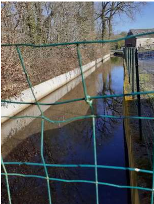
Bassin de confinement situé sur le point bas du site
