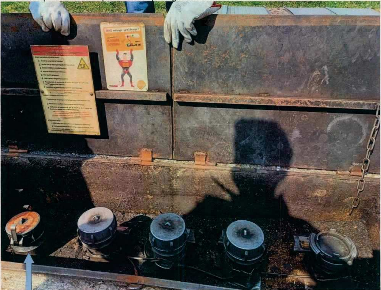
Bouche d'évacuation des vapeurs destinée à être raccordée à la citerne de transport
