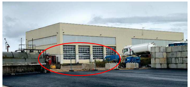
Clôture provisoire entre Urano et Bemaco
