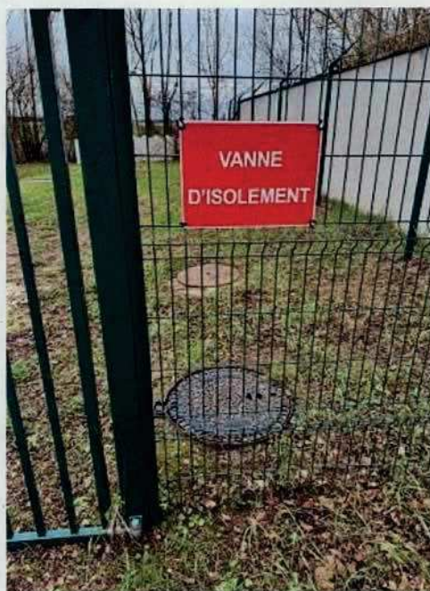
SIGNALISATION VANNE ISOLEMENT
