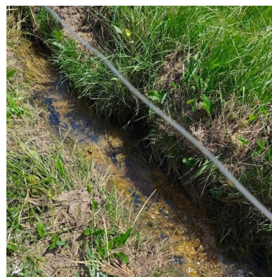
Suintement d'huile au niveau d'un regard d'eau pluviale en-dessous de la génératrice inférieure de la buse PVC grise (descente d'eau de pluie en toiture)
