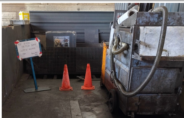
Zone de lavage à l'arrêt
