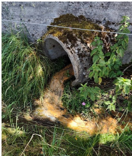
Sortie de buse passant sous la RD500
