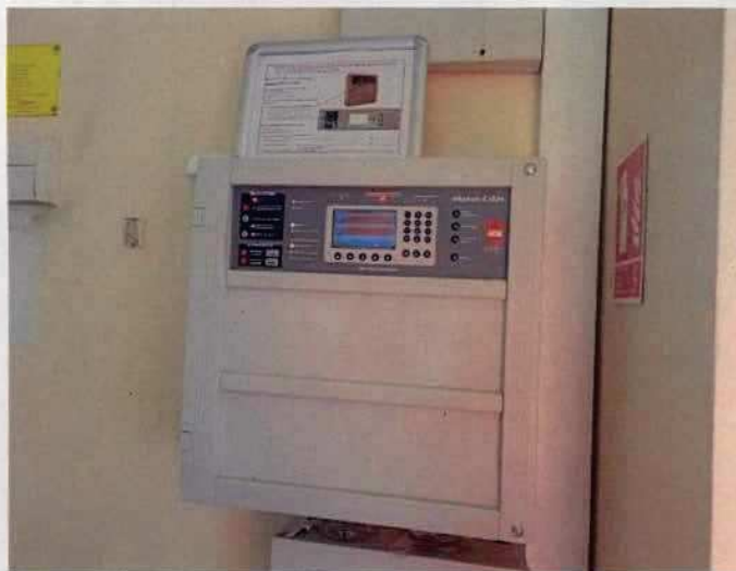
Système de détection incendie
