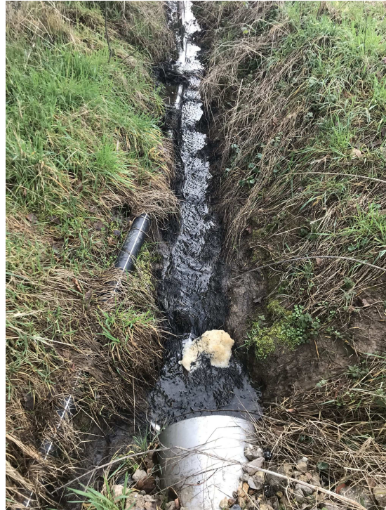
Fossé le long de la distillerie
