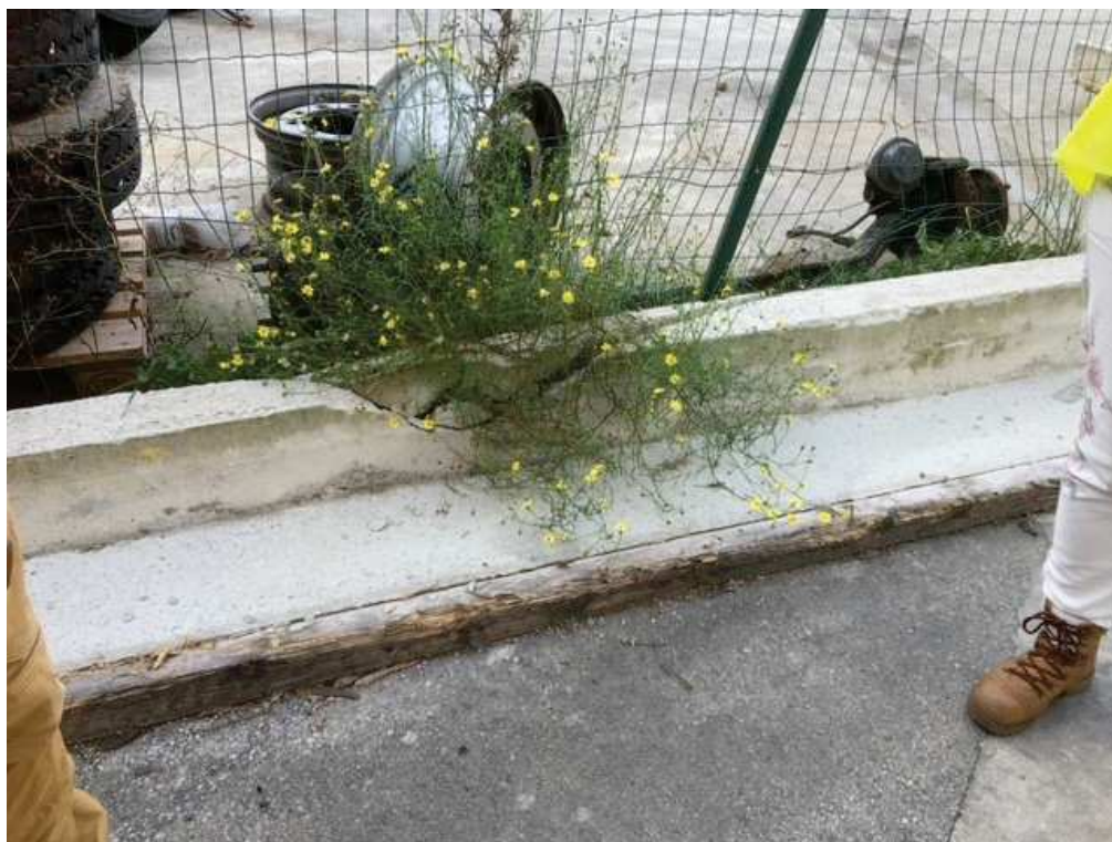
Muret d'enceinte détérioré
