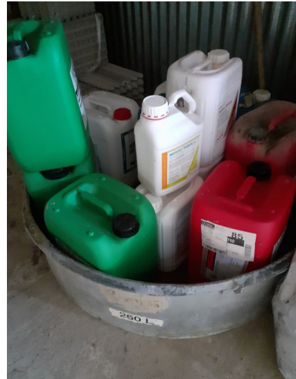
Bac de rétention sous les produits dangereux
