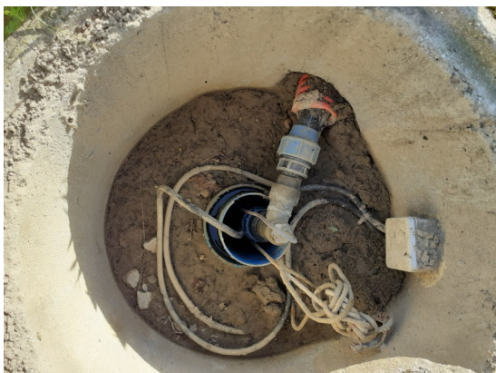
Tête de forage non surélevée pour le forage F2
