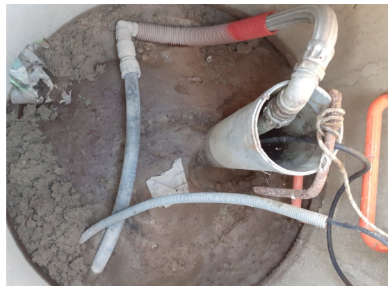
Tête de forage conforme pour le forage F1
